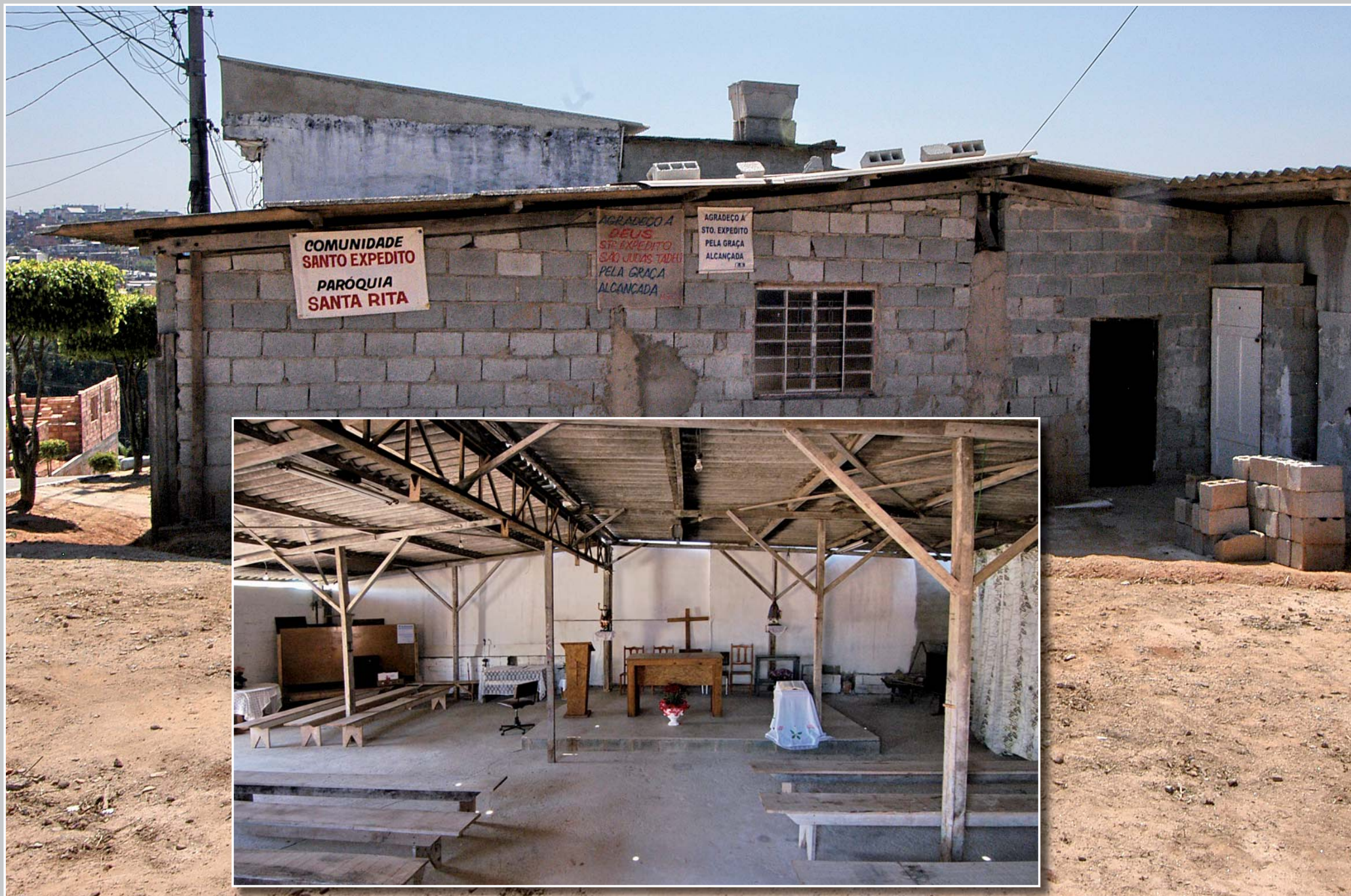
Ohne das Schild am Gebäude zu beachten, käme man wohl nicht auf die Idee, dass hier eine Kirche entsteht und bereits genutzt wird.
